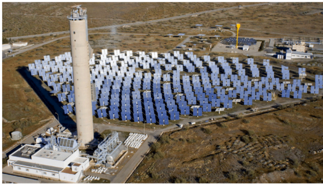
Fig. 5. Heliostats field for CSP in Plataforma Solar de Almería [17].
